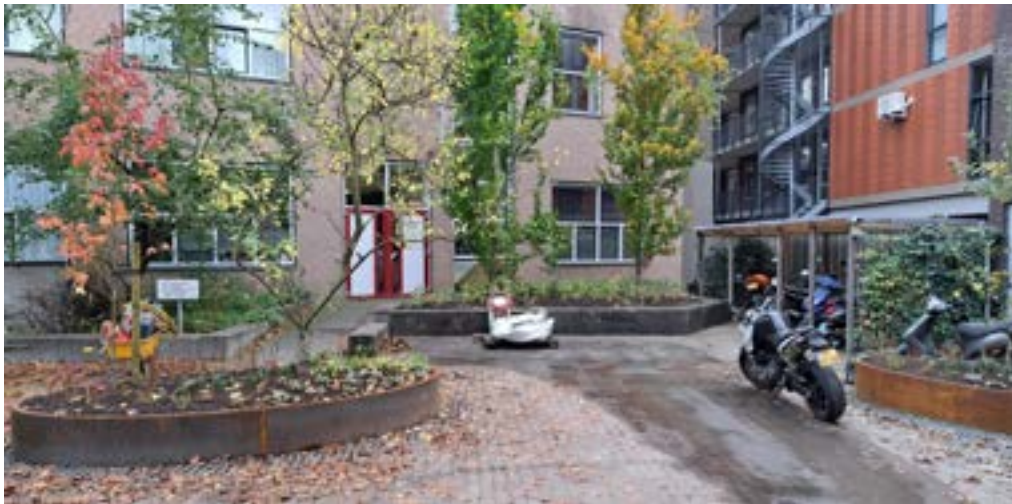
Het binnenterrein van de W.A. Scholtenstraat.
